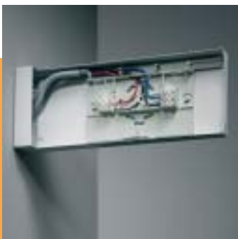
Bügel montieren und Leuchte verdrahten
