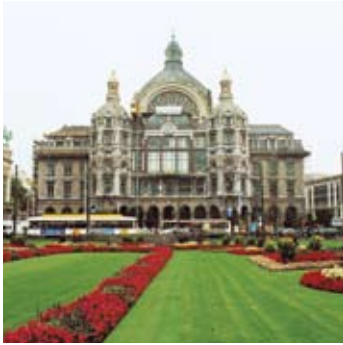
Sicher in öffentlichen Gebäuden
