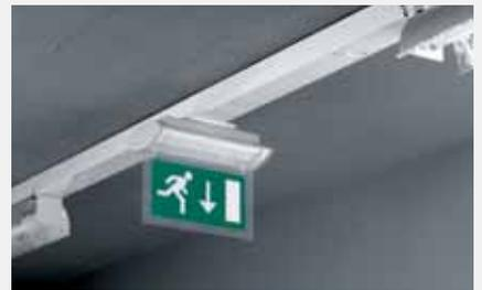
E4 mit LED-Modul für Sicherheitsbeleuchtung
