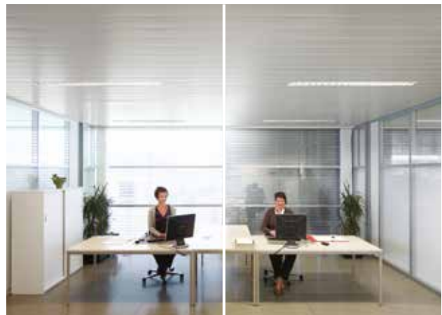
Tageslichtabhängige Regelung passt den Leuchtenlichtstrom auf Basis des einfallenden Tageslichts an.
